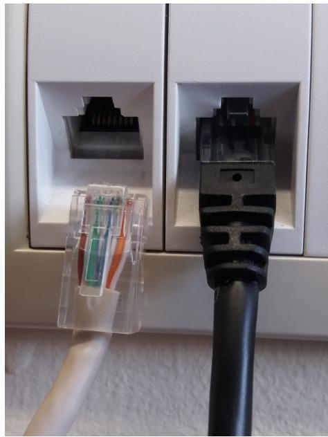
Slika 5.4: Utičnice i utikači 8P8C („RJ45”).
